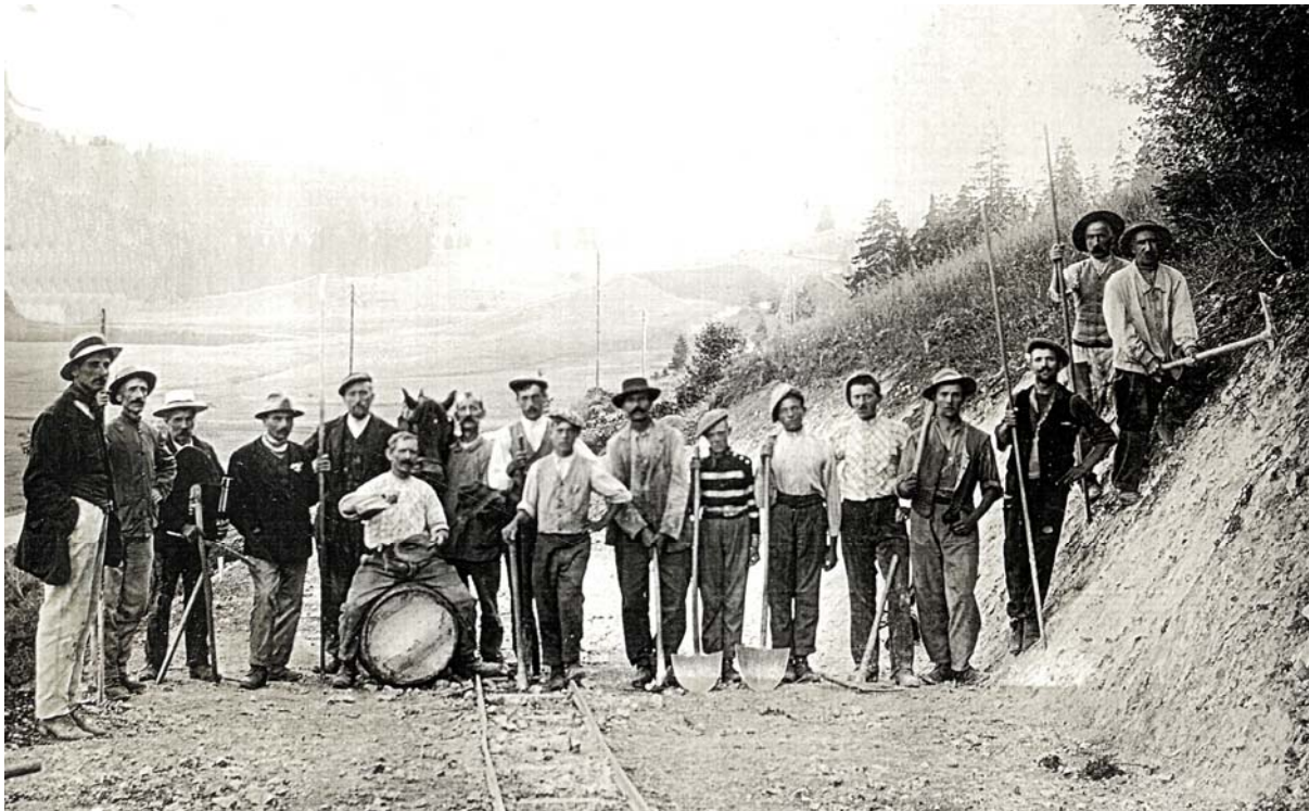
Construction de l'embranchement sud-ouest de la route des environs du Séchey au Bonhomme. Ces travaux se sont effectués, pour les deux embranchements, en 1909 et 1915.
